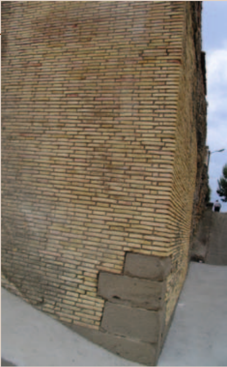
Esquina N.O. del palacio, obra de ladrillo y cantonera inferior de sillares, destruida recientemente
