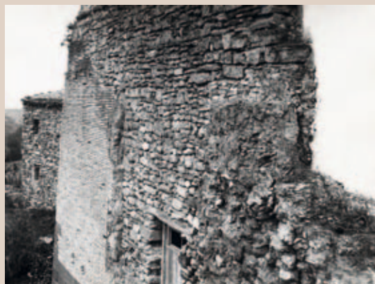
Muro recientemente desaparecido, que daba acceso a las bodegas por el oeste
