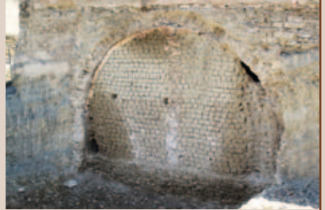
Segmento de bodega condal recientemente destruido.
